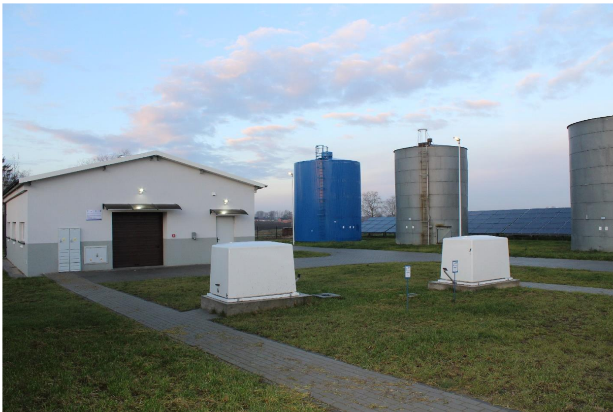
Przebudowana Stacja Uzdatniania Wody w Oporowie
