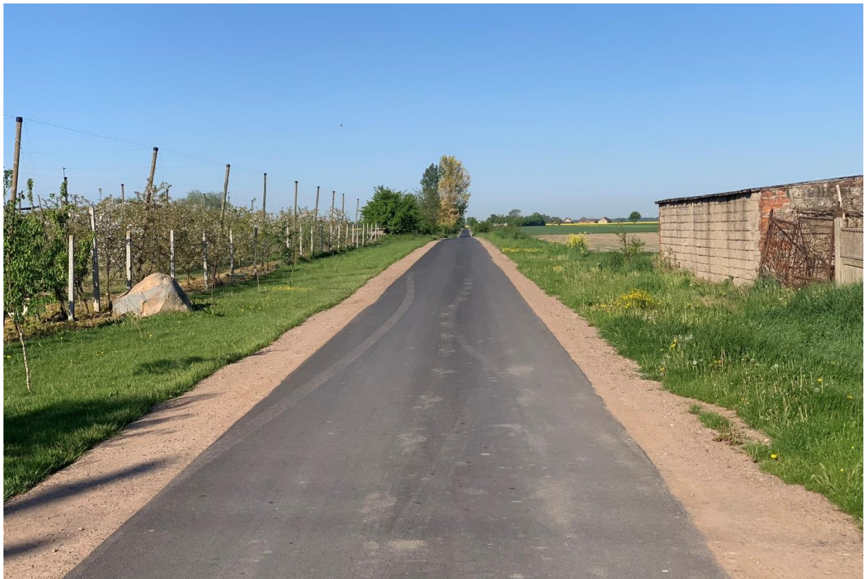
Droga gminna Kurów-Wieś - Halinów po remoncie
